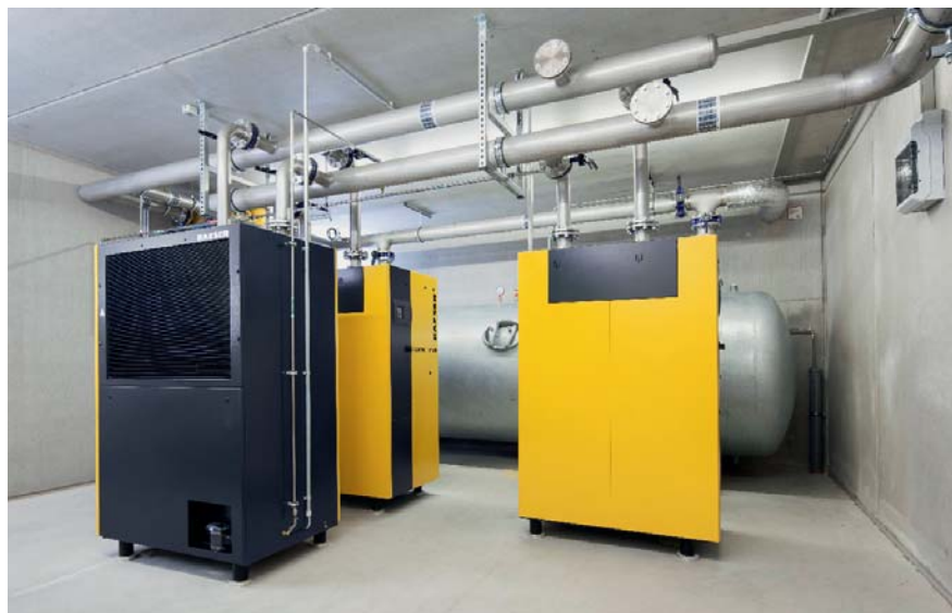
Grazie ai nuovi essiccatori a ciclo frigorifero con tecnologia Secotec ad accumulo di calore latente si risparmiano molti soldi
