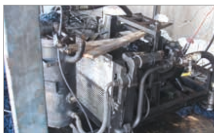
Fig. 1: Sistema d'aria compressa trascurato
