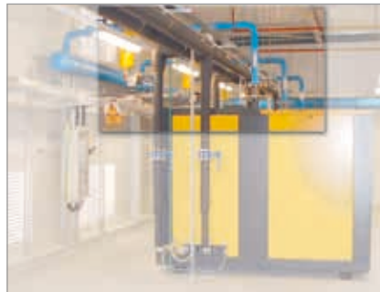
Fig. 3b: Giunti elastici del compressore con compensatori assiali
