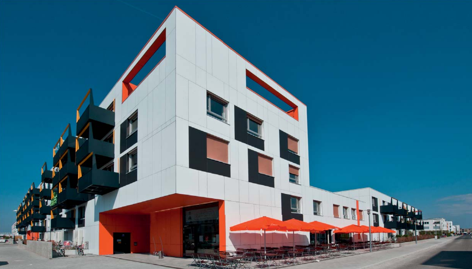
Progetto: Condominio wagnis 3, Monaco Studio di architettura: Bogevischs Büro, Monaco Foto: Eternit GmbH, Bogevischs Büro Prodotto: Rivestimento di facciata EQUITONE [pictura]
