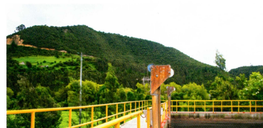
Impianto di depurazione La Calera
