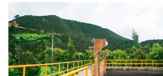
Impianto di depurazione La Calera
