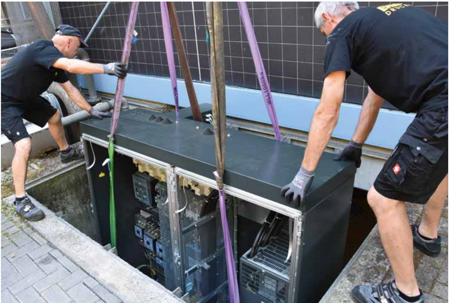
Il corpo della macchina è stato infilato attraverso il lucernario.
