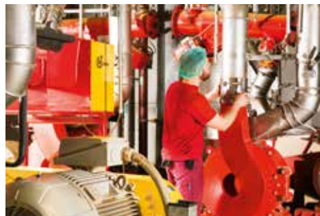
L'aria compressa è necessaria in tutte le fasi di lavorazione: ad esempio, nella movimentazione dei prodotti.
