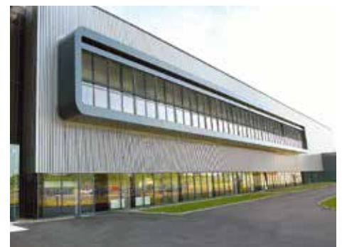
Lo stabilimento 4 a Reichersberg (Alta Austria): qui la FACC realizza le carenature e componenti per motori in costruzione leggera.
