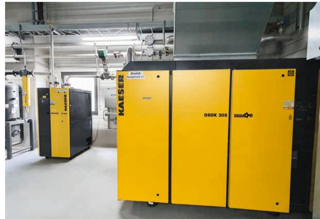
*Il compressore a vite KAESER, mod. DSDX 305, eroga la cosiddetta aria di soffiaggio per i picchi di consumo temporanei.*
