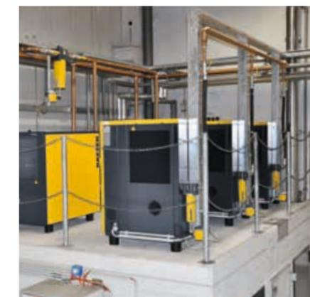
La stazione d’aria compressa troneggia nel padiglione di produzione nel quale si accumula l’aria calda che genera temperature più elevate.
