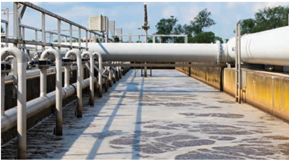
In alto: una turbosoffiante Pillaerator LP 8000 eroga l'aria necessaria per i bacini di aerazione. In basso: la depurazione biologica avviene in tutti i 6 bacini di aerazione.
