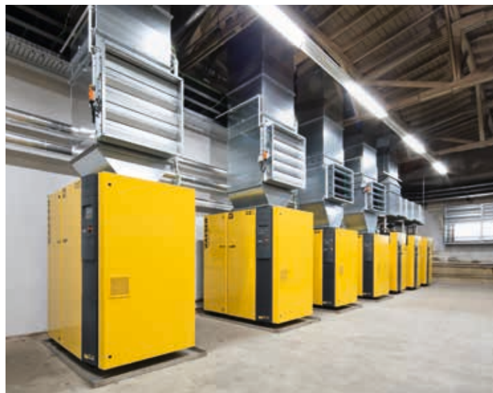
Due compressori a vite KAESER, modello CSD 105 e BSD 75, convogliano l'aria compressa per l'intero stabilimento.
