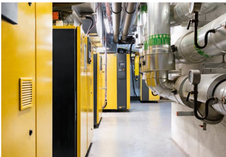
La stazione è già predisposta per un successivo utilizzo del recupero di calore, grazie al quale si possono conseguire ulteriori grandi risparmi.
