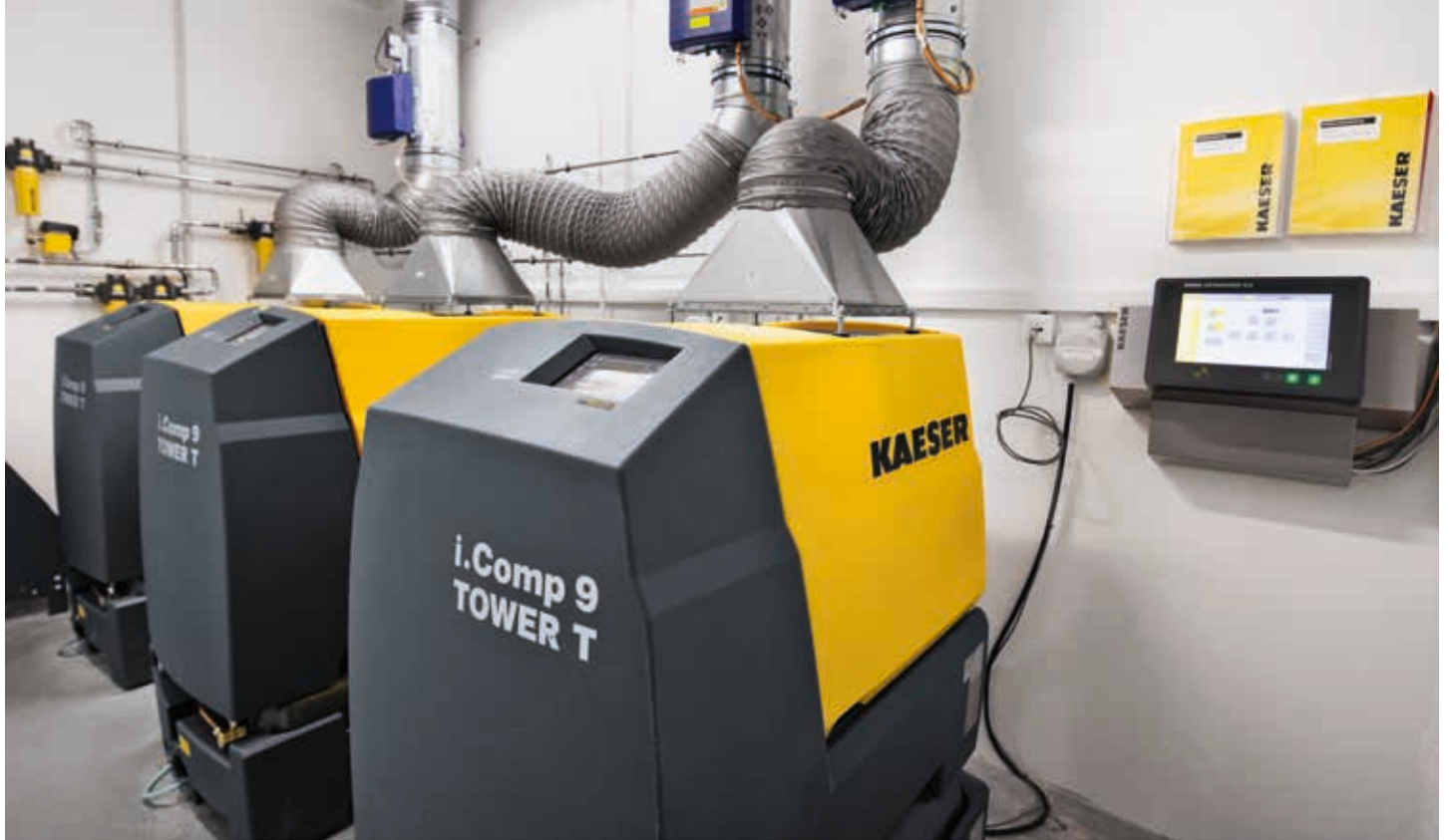
Tre compressori KAESER i.Comp 9 Tower assicurano che il grande laboratorio non rimanga mai a corto d'aria.
