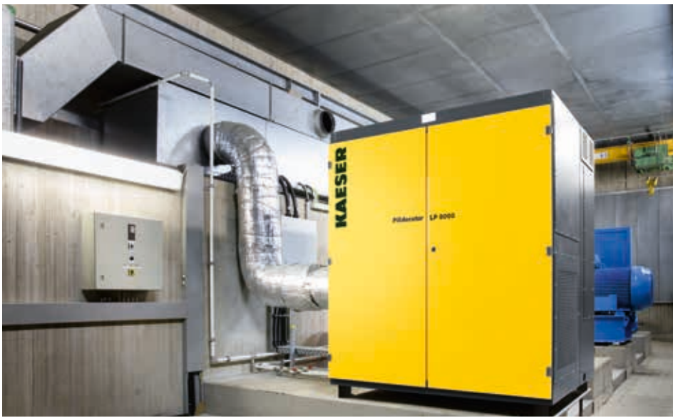
In alto: una turbosoffiante Pillaerator LP 8000 eroga l'aria necessaria per i bacini di aerazione. In basso: la depurazione biologica avviene in tutti i 6 bacini di aerazione.
