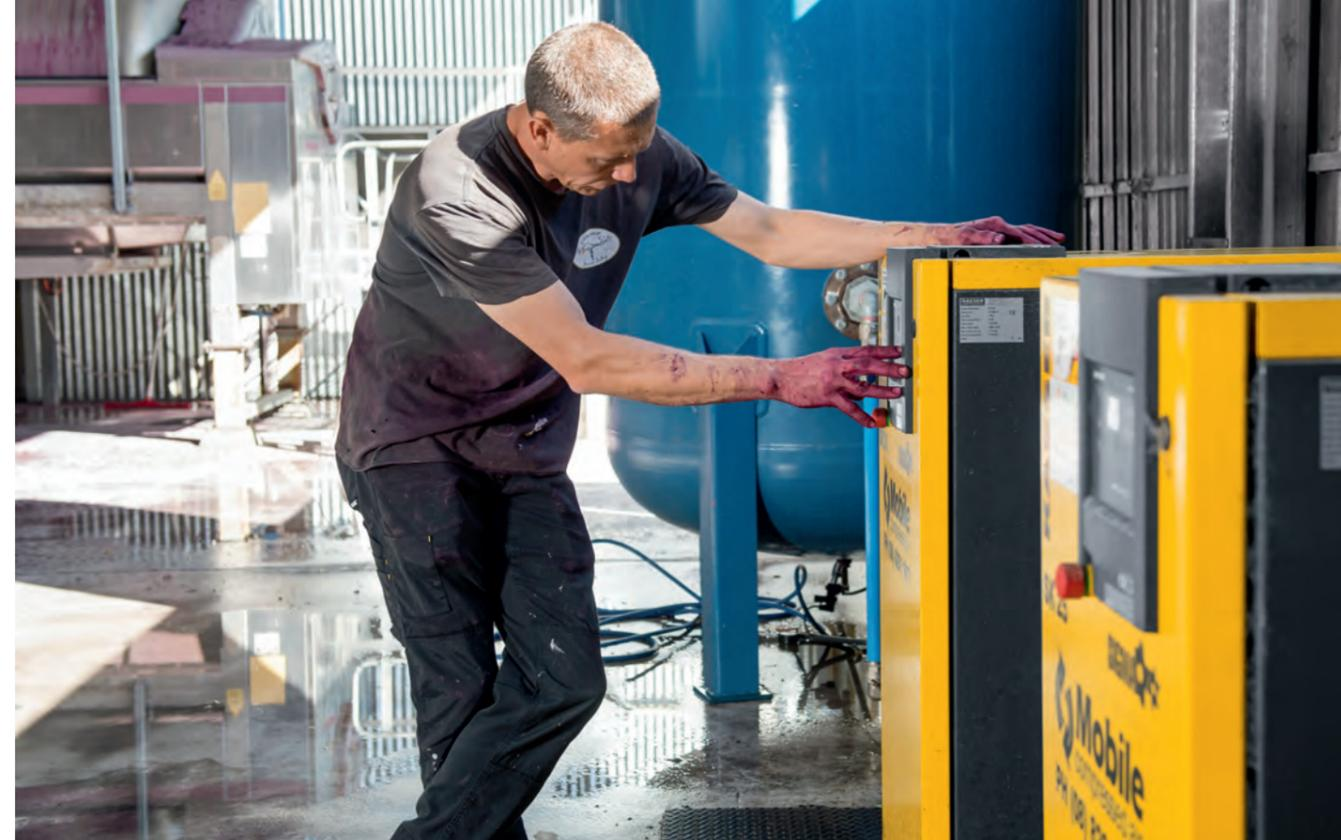
nuovi compressori. Dopo aver analizzato le esigenze del nuovo impianto, sono stati acquistati due compressori a vite KAESER, modello SK 25, e un serbatoio di aria compressa con una capacità di 5.000 litri. La serie SK KAESER offre l'affidabilità e l'efficienza di cui Teusner ha bisogno, garantendo non solo più aria compressa a
