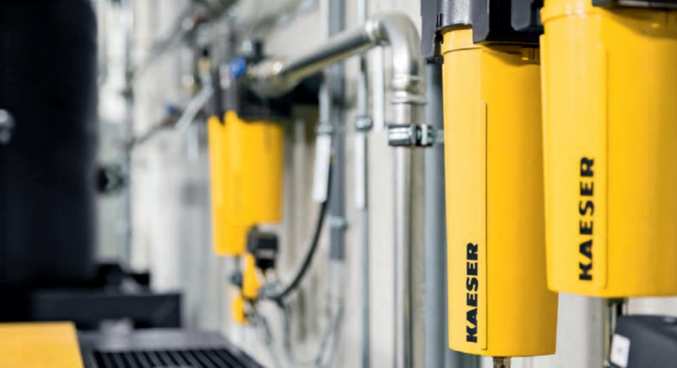
Essiccatori a ciclo frigorifero mod. TL 1301 o ABT 25, colonne di adsorbimento a carboni attivi, microfiltri (prefiltri), filtri di sicurezza per garantire particolato di classe 1 e diversi altri dispositivi di filtraggio assicurano aria compressa di alta qualità.
