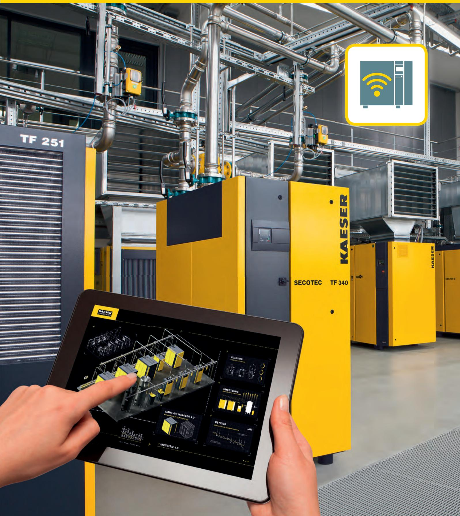
SIGMA AIR MANAGER 4.0 in sintonia con la gestione tecnica centralizzata
