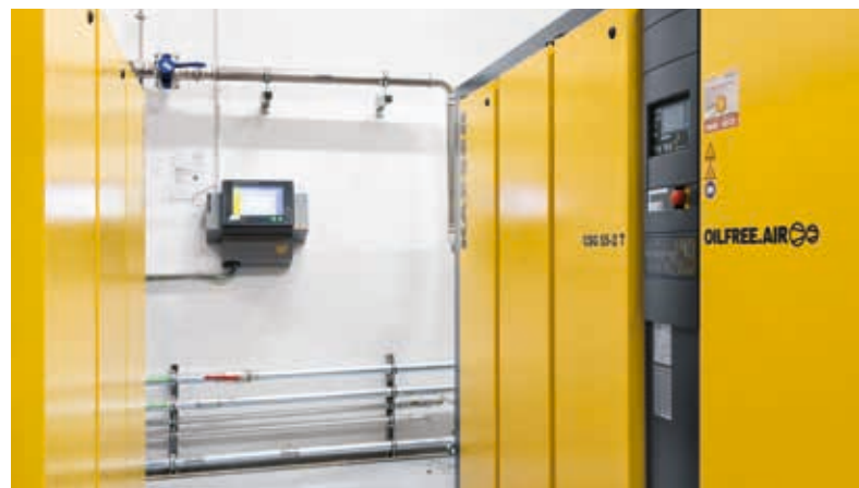
Il SIGMA AIR MANAGER 4.0 assicura un controllo efficiente sotto il profilo energetico.
