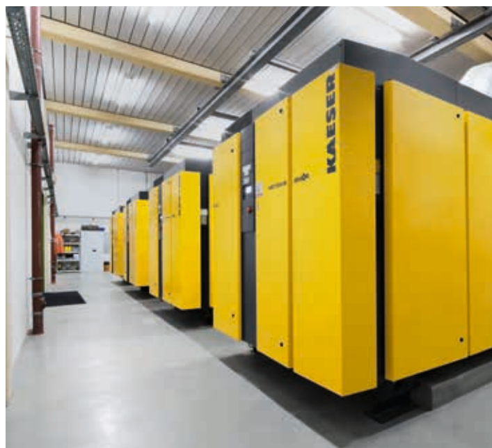
Le quattro soffianti a vite KAESER, modello HBS.
