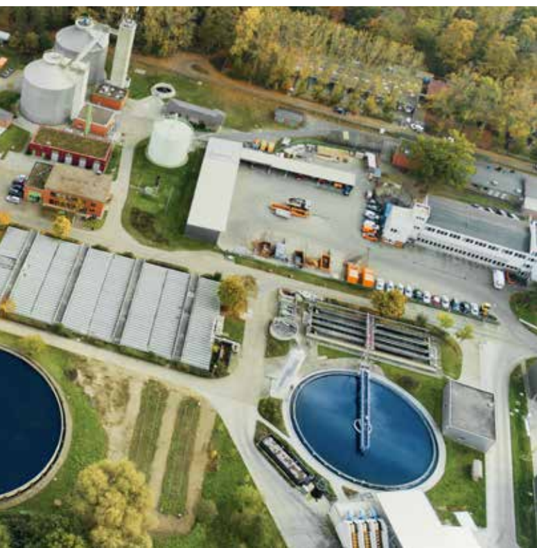
Vista dall'alto dell'impianto di depurazione e trattamento delle acque reflue della città anseatica di Lüneburg.
