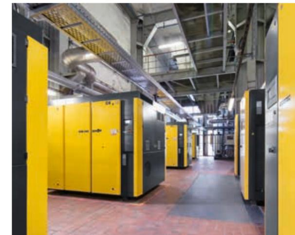
Nella stazione di aria compressa sono complessivamente in funzione quattro compressori a vite con PROFILO SIGMA a risparmio energetico e motori di classe IE4.
