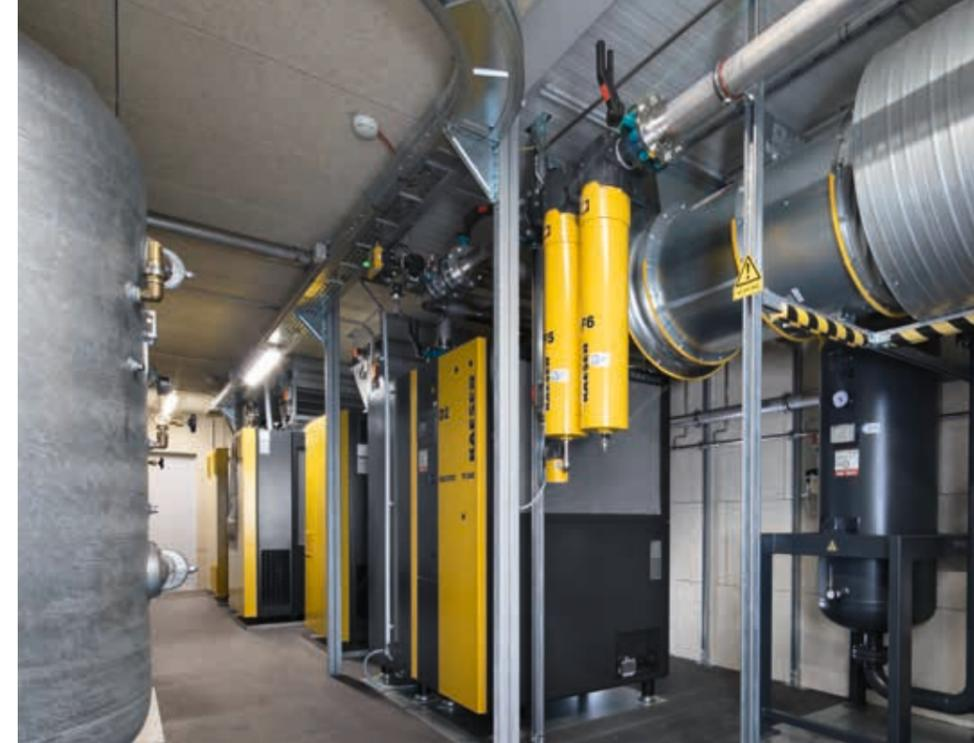
Per rispettare i limiti di emissione sonora, il container in cui è alloggiata la stazione di aria compressa è stato completamente insonorizzato con rivestimenti fonoassorbenti.
