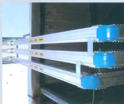
Installazione con HBS 110.
