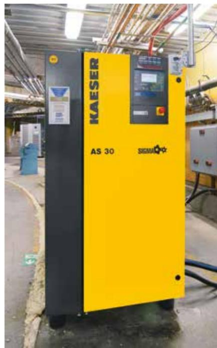
**Il compressore a vite KAESER, modello AS 30, deve soddisfare requisiti altamente specifici a un'altitudine di 4200 s.l.m.**
