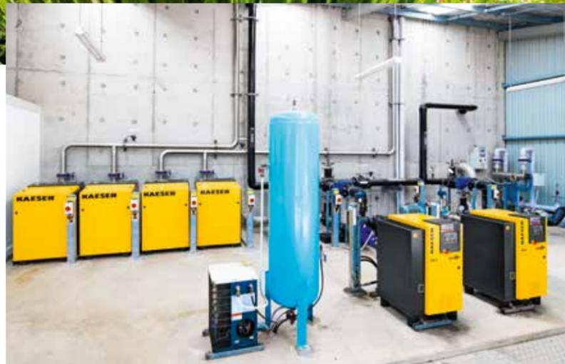
*Quattro soffianti rotative a lobi KAESER, serie COMPACT, erogano l'aria di processo per il bioreattore a membrana.*
